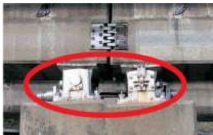
P C軌道桁落橋防止工事・・・P C軌道桁の支承を連結し落橋を防止する。
