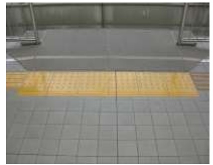
警告ブロック
