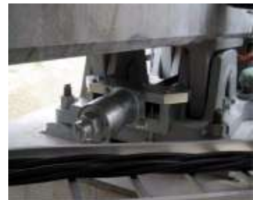
P C軌道桁落橋防止工事・・・P C軌道桁の支承を連結し落橋を防止する。
